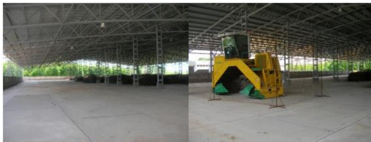
Stația de compostare Galați
