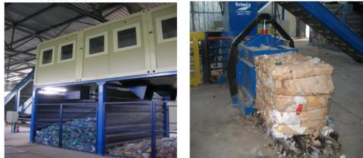
Stația de sortare Galați
